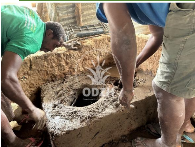
Processo de construção de fogão melhorado
